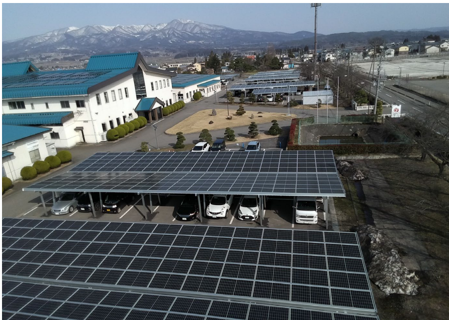
【上の写真】 マツモトプレジジョン株式会社設置の屋根置きおよびソーラーカーポート
